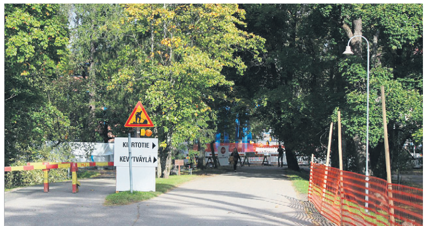
Hallintorakennuksen työmaa vaikeuttaa kampuksella liikkumista.
